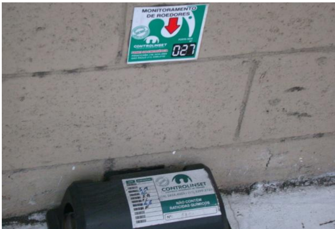
Figura 4.2.6.8.2-3: Uso de porta-iscas para controle em terminal arrendado (Fonte: Codesp, 2010).
