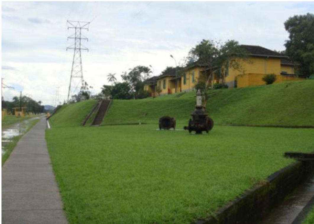
Figura 4.2.2.1.10-3: Área da Usina de Itatinga com destaque para a linha de transmissão.
