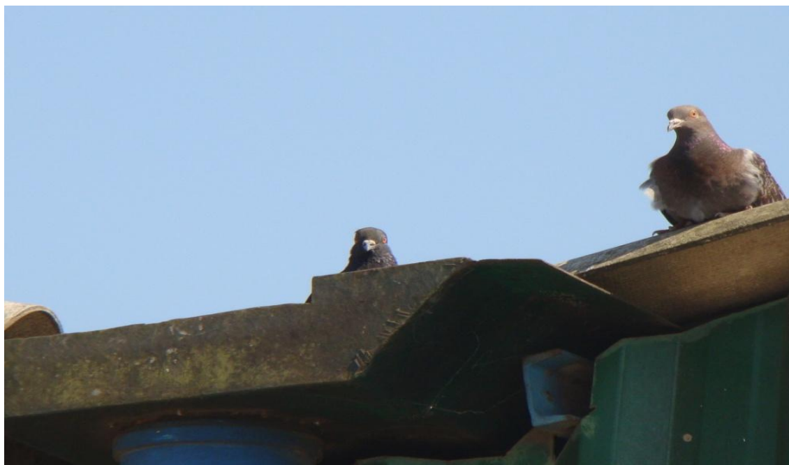
Figura 4.2.6.8.1-23: Pombos utilizando-se de água estagnada em calha do Ogmo - ponto de escalação 2 – Outeirinhos (Fonte: Codesp, 2010).
