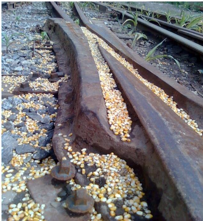
Figura 4.2.6.8.1-3: Grãos depositados junto as linhas férreas, por defeito em bicas de vagões graneleiros (fonte: Codesp, 2010).
