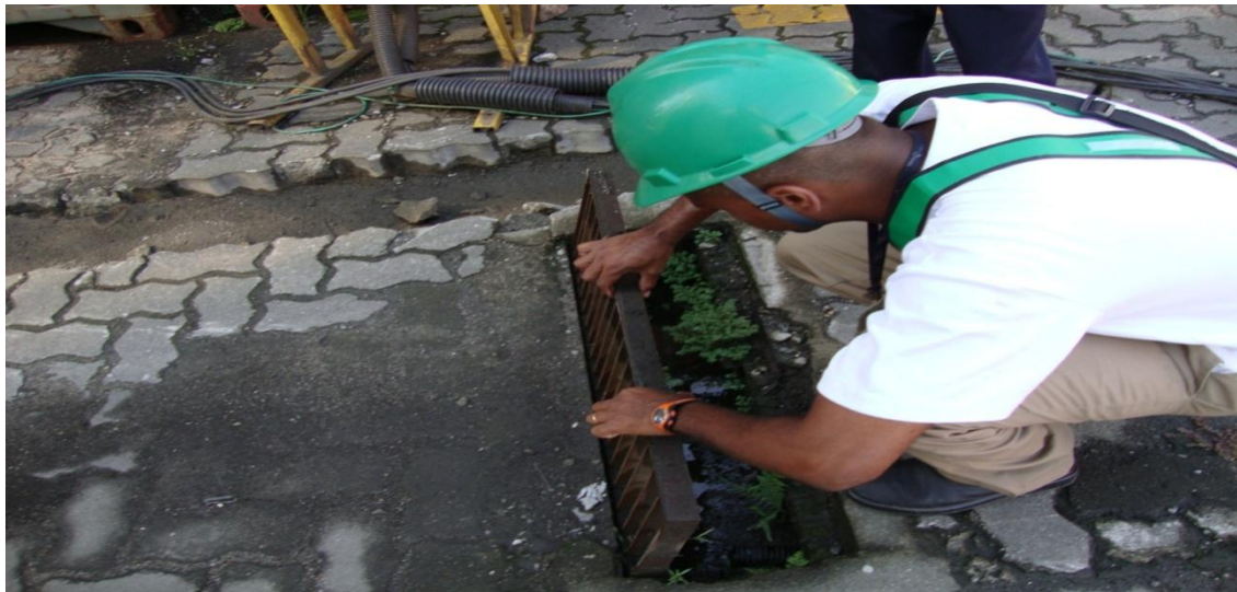
Figura 4.2.6.8.3-6: Técnico de empresa vistoriando bueiro em campanha do tipo mutirão (Fonte: Codesp, 2010).
