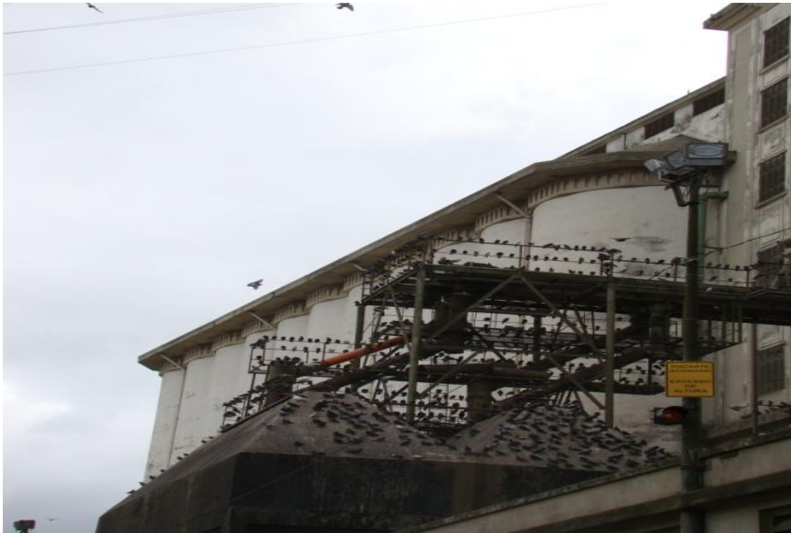
Figura 4.2.6.8.1-1: Pombos utilizando-se das instalações do Moinho Pacífico (Fonte: Codesp, 2010)
