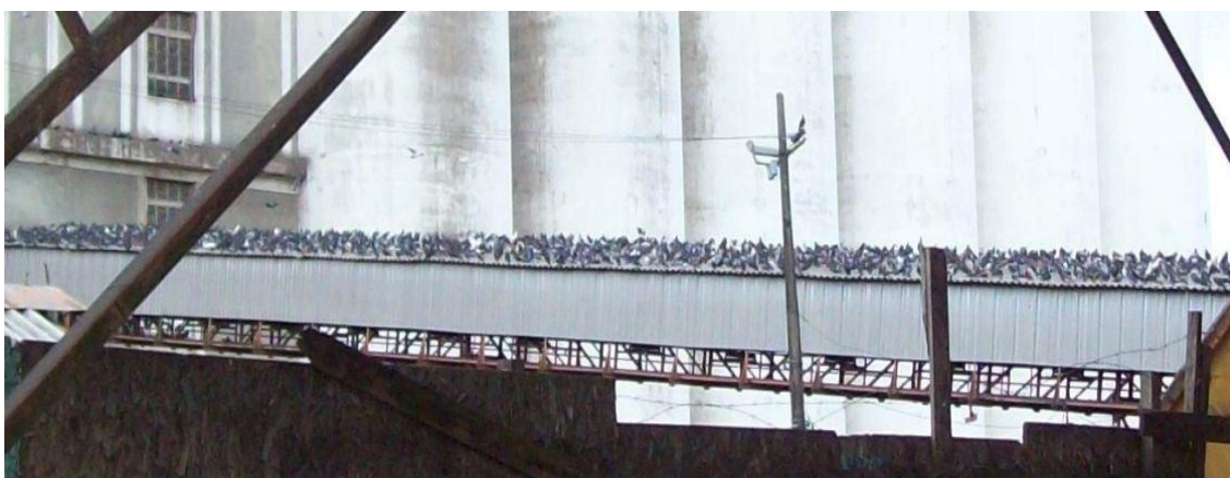
Figura 4.2.6.8.1-21: Cobertura da esteira do T-Grão afetada por pombos (Fonte: LSI Assessoria e Consultoria, 2010).
