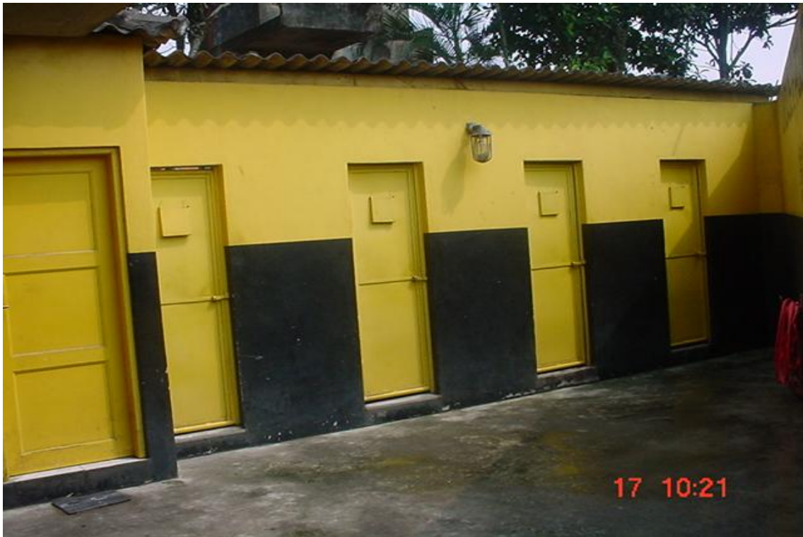
Figura 4.2.6.8.4-10: Instalações do canil da Guarda (Fonte: Codesp, 2010).
