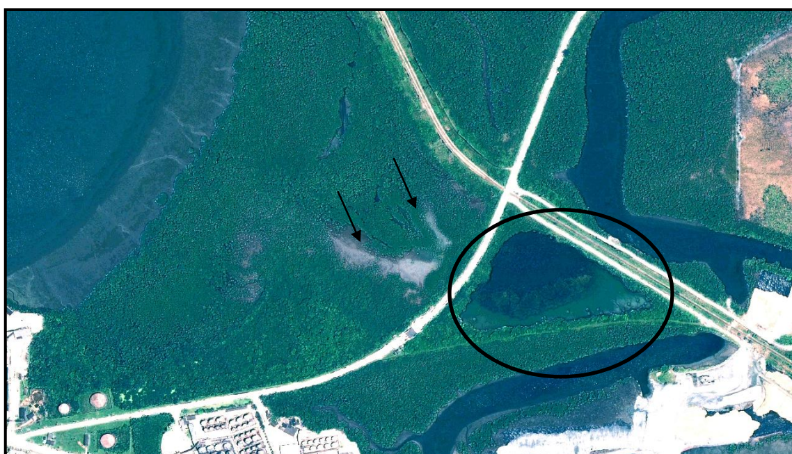
Figura 4.2.2.2.5-13: Detalhe da ilha Barnabé indicando a presença do corpo d'água e de clareiras devido à construção de estradas de acesso à ilha
