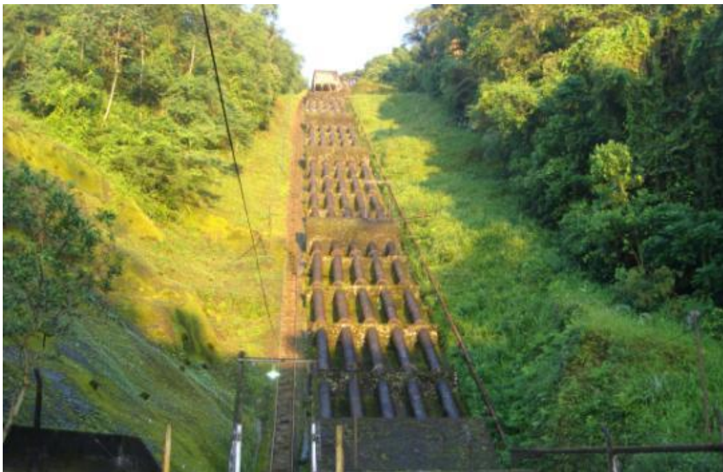
Figura 4.2.2.1.10-2: Área da Usina de Itatinga com destaque para os dutos d'água por entre a Floresta Ombrófila Densa.
