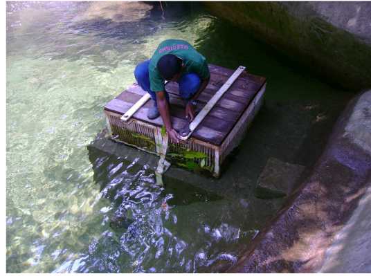
Figura 04 – Limpeza do Gradeamento
