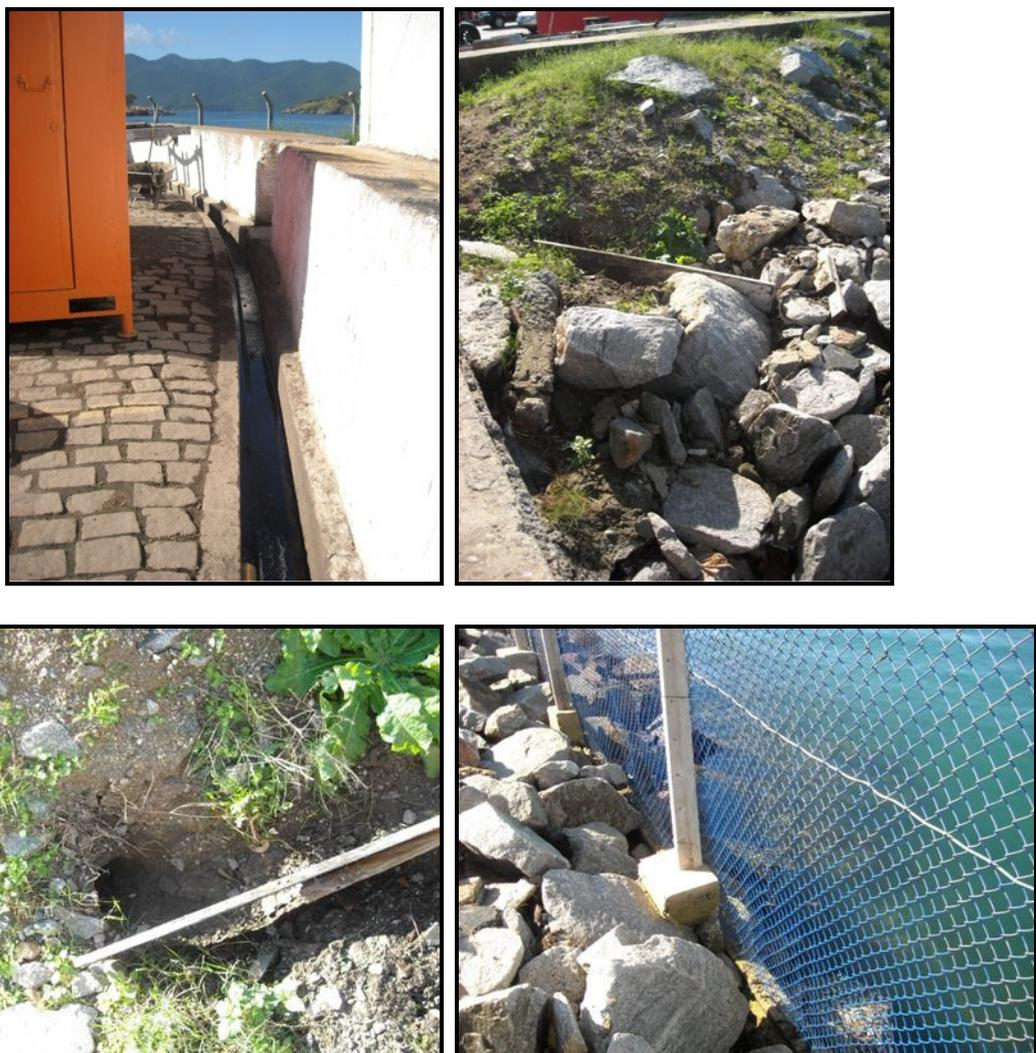
**Figura 11 – Canaleta de drenagem aos fundos da manutenção e saída do tubo na área de enrocamento.**
