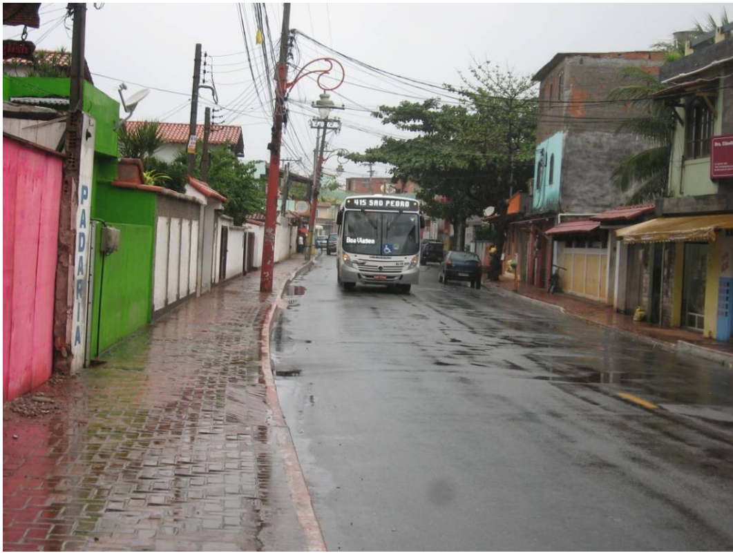
Foto D - Na falta de sinalização divisória de pista o comportamento dos motoristas acaba sendo inadequado e o veículo circula no meio da pista
