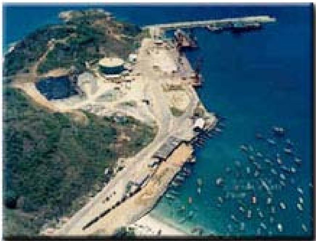
PORTO DO FORNO - VISTA GERAL
