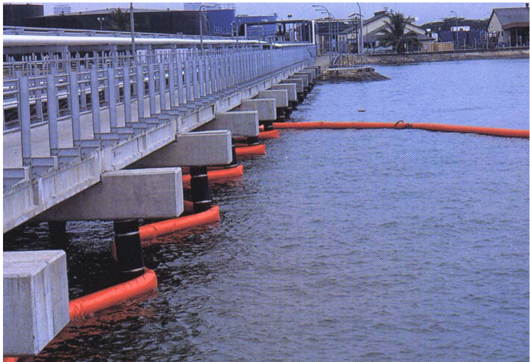
Fig. 7 k – Barreira em Proteção
