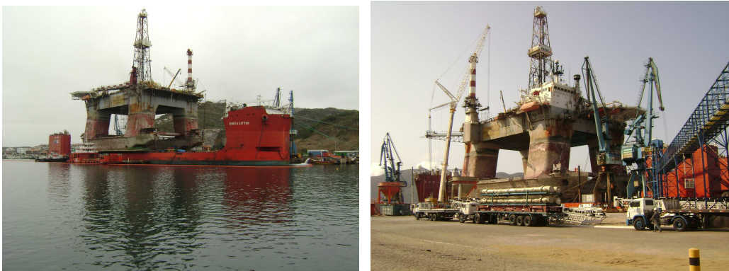
Figura 2.4. Emprego de navios doca para reparo de plataformas no Porto do Forno.
