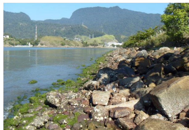
Figura 2.1.5 - Região onde se localiza o ponto PA-4, no corpo de água marinho adjacente ao Porto em frente ao extravasador.
