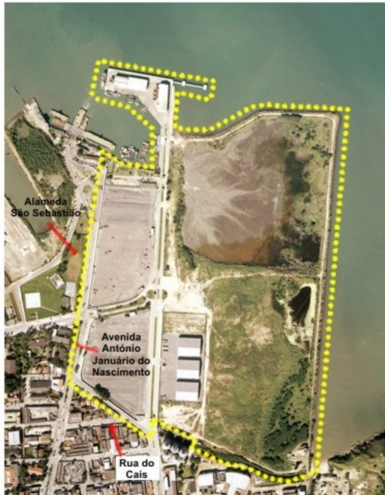
Figura 2.3-1 – Limites do Porto Público de São Sebastião
