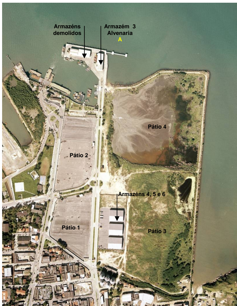
Figura 3.4 - Instalação de armazenagem
