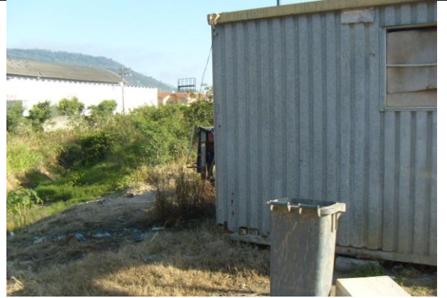
Figura 2 - Área adjacente ao ponto PA-2, mostrando a influência de descargas de esgoto no corpo de água.
