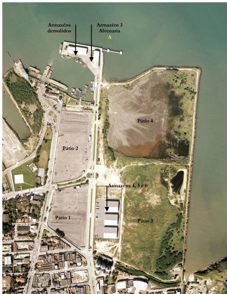
Figura 3.2.7-1. Instalação de armazenagem
