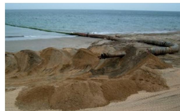
Linha de recalque utilizada para o lançamento do material dragado diretamente no ambiente praiar. Fonte: <http://throughthesandglass.typepad.com>.
