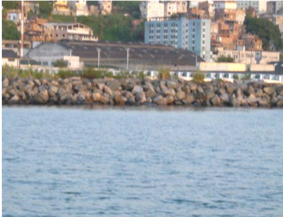
Foto 3 - Enrocamento existente na área do empreendimento
