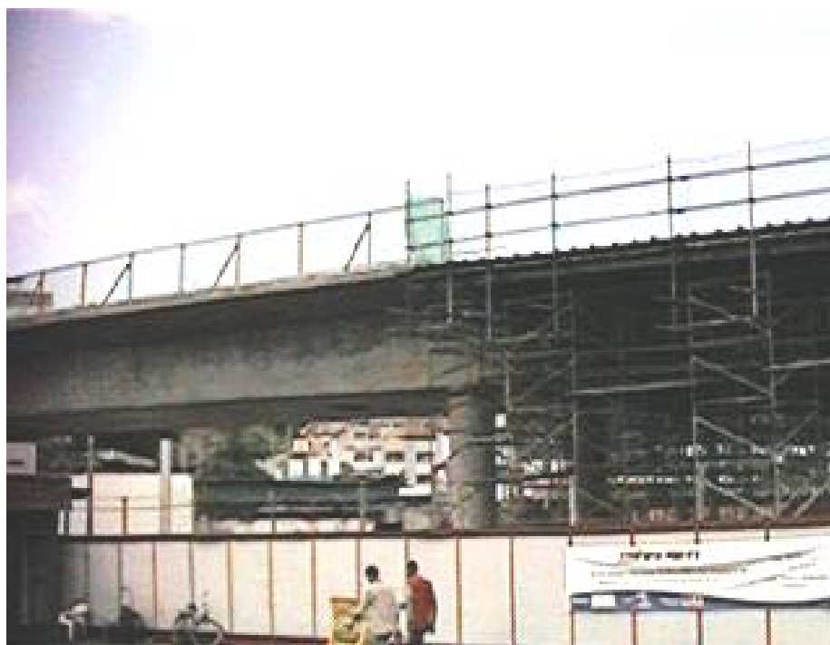
Foto 23 - Obras da alça de acesso a área da CODEBA
