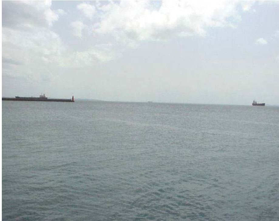
Foto 35 - Extremo norte do quebra-mar.
