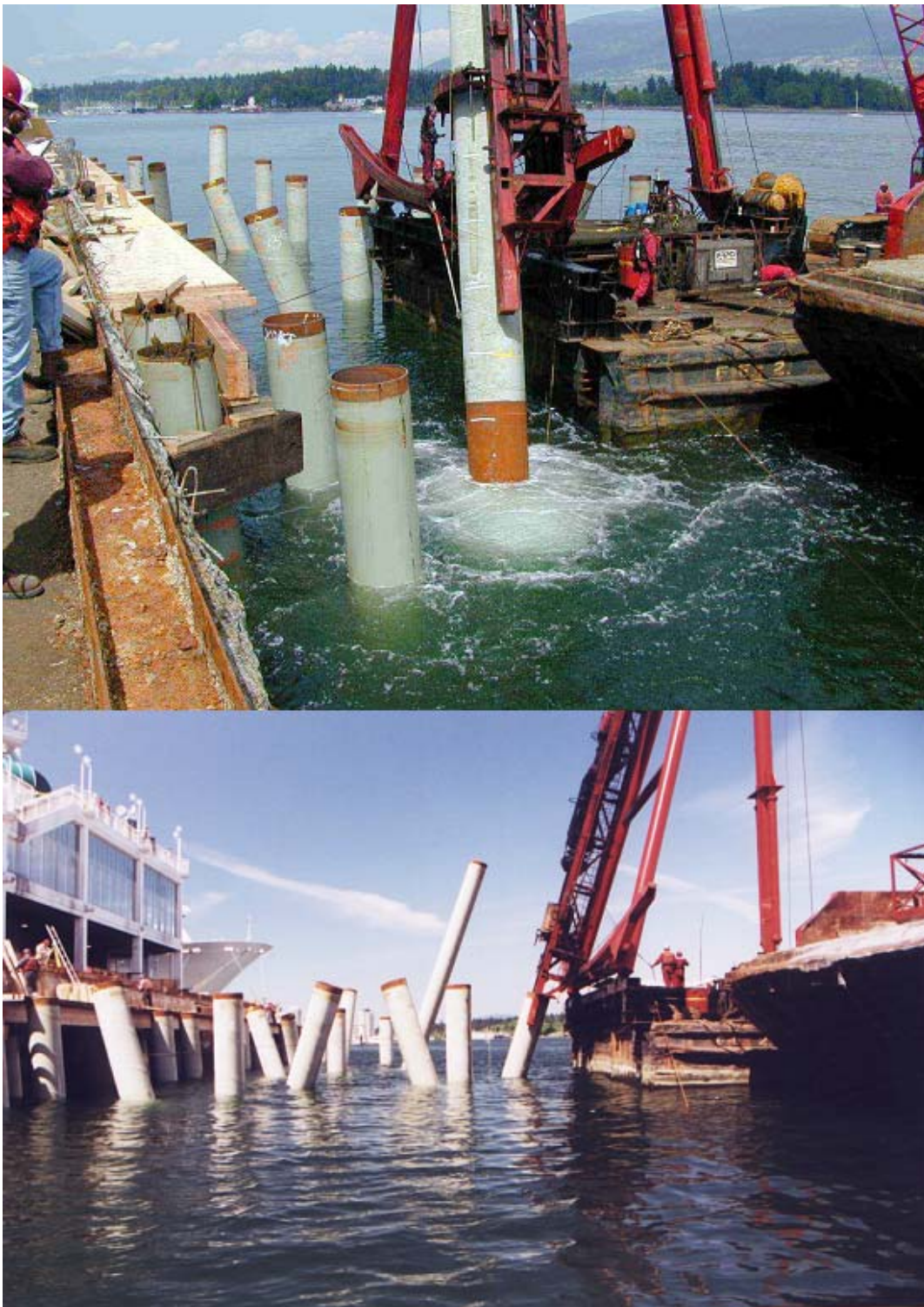
Figura 34 - Equipamento do tipo martelo de impacto em operação na cravação de estacas de fundação de um cais
