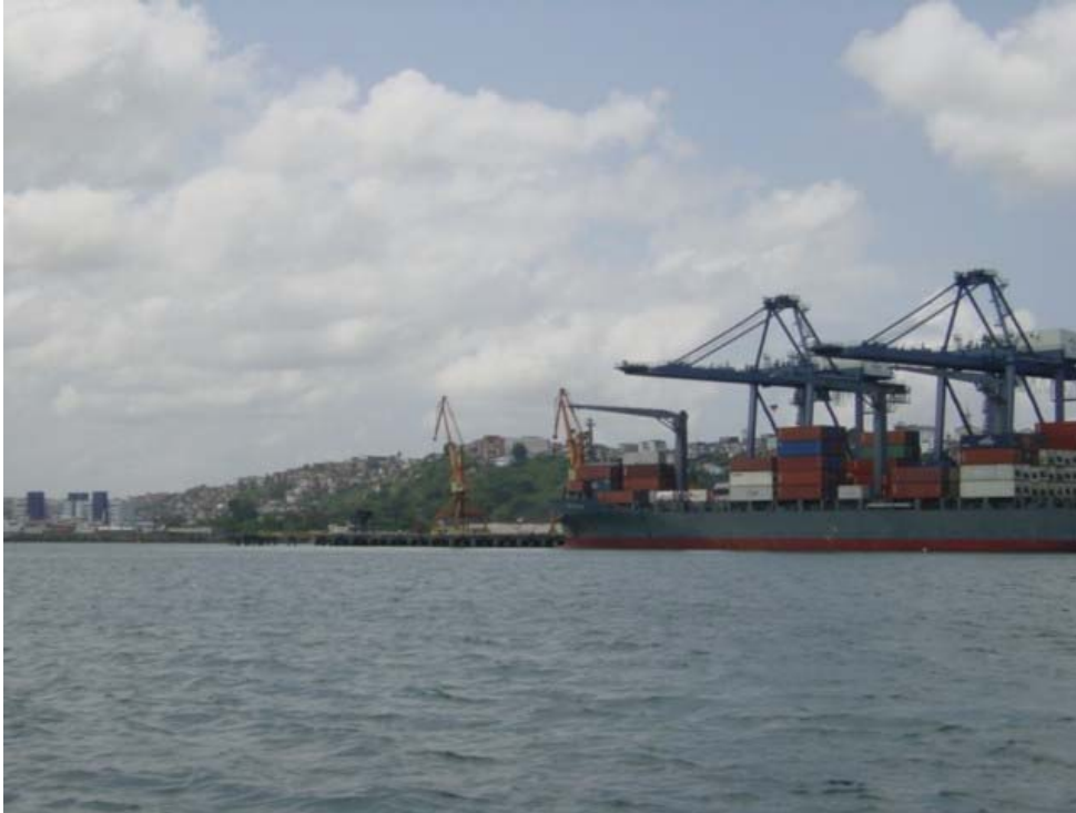
Figura 9: Portaineres em operação de carregamento de navio
