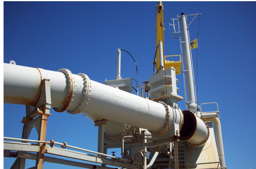
Foto 4: Sistema de recalque de material pela proa desativado.
