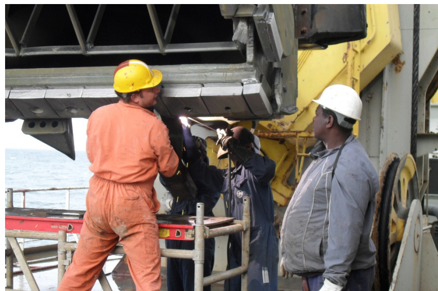
Foto II.8: Realização de modificações no boca de dragagem.
