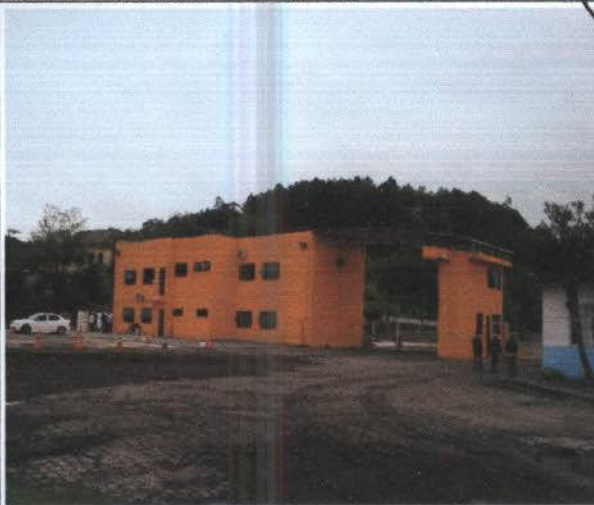
FOTO 02: Prédio da administração do Porto de Antonina reformado.
