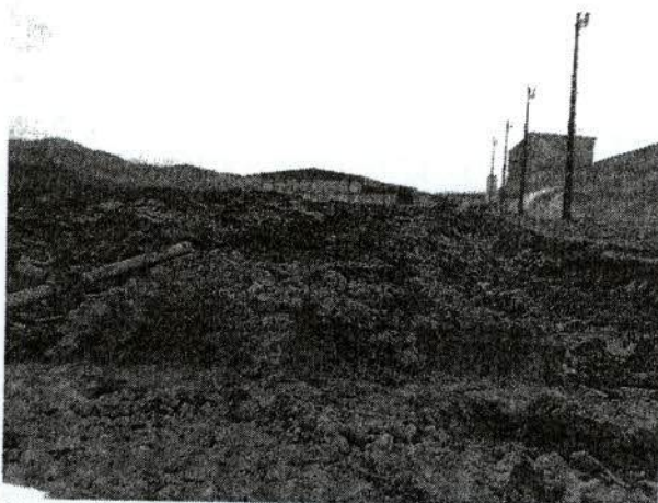
Figura 55 – Obra de construção de estacionamento
