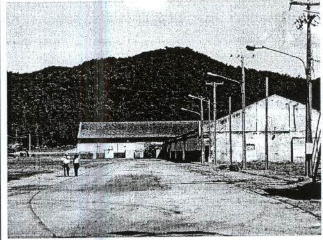
Figura 5: armazéns na retroárea, com sinais de deterioração e pouca utilização. (UTM 22J 731834 / 7183804)
