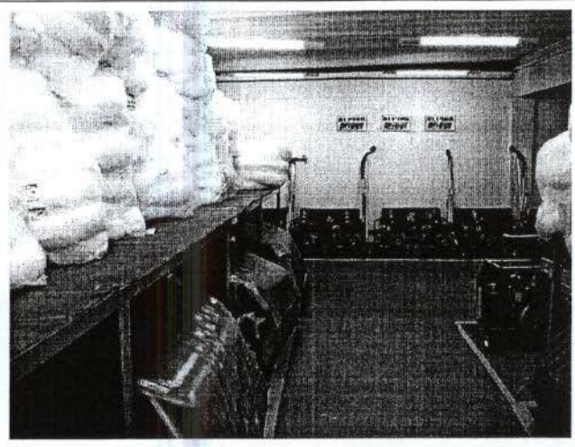
Figura 8: equipamentos e material recentemente adquiridos para contenção de acidentes com óleo e outras substâncias (para absorção, controle e recolhimento) (UTM 22J 749864 / 7176817)
