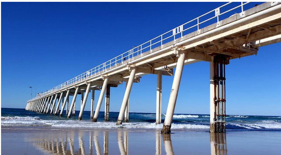
Figura 4.2 - Estrutura fixa para o sistema de bombas de sucção e linha de recalque1
