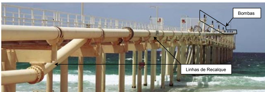
Figura 4.3 - Estrutura fixa para o sistema de bombas de sucção e linha de recalque2
