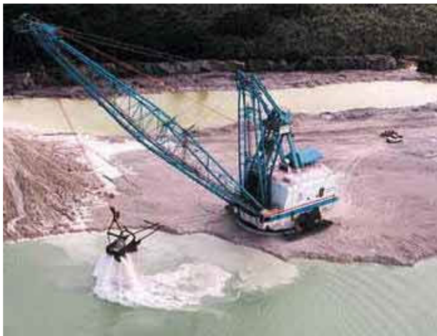
Figura 4.13 - Operação de Dragline em Miami, Estados Unidos 10
