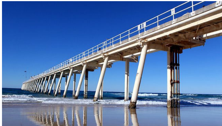
Figura 3.39 - Ilustração do Sistema de Transpasse de Sedimento (Tweed River, Australia)
