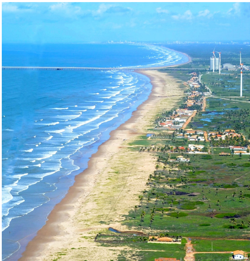
Figura 1.5 - Detalhe do saliente criado na zona de sombra do Terminal Inácio Barbosa. Observar que o trecho de praia situado imediatamente à jusante do saliente encontra-se em erosão. Aracaju ao fundo
