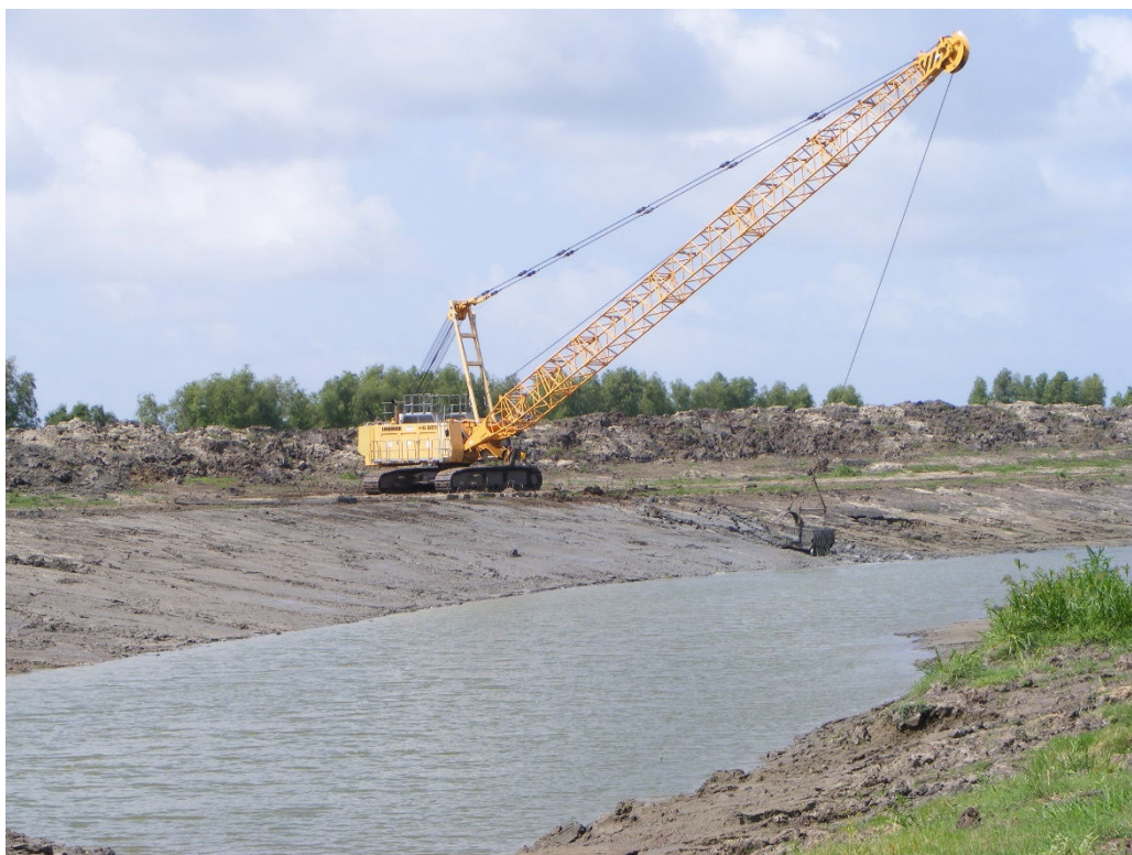
Figura 4.12 - Operação de Dragline em Louisiana, Estados Unidos 9
