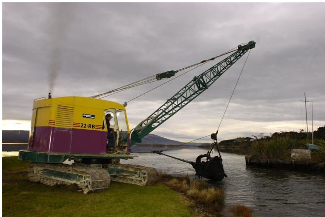
Figura 4.11 - Operação de Dragline no Lago Waihola, Nova Zelândia 8
