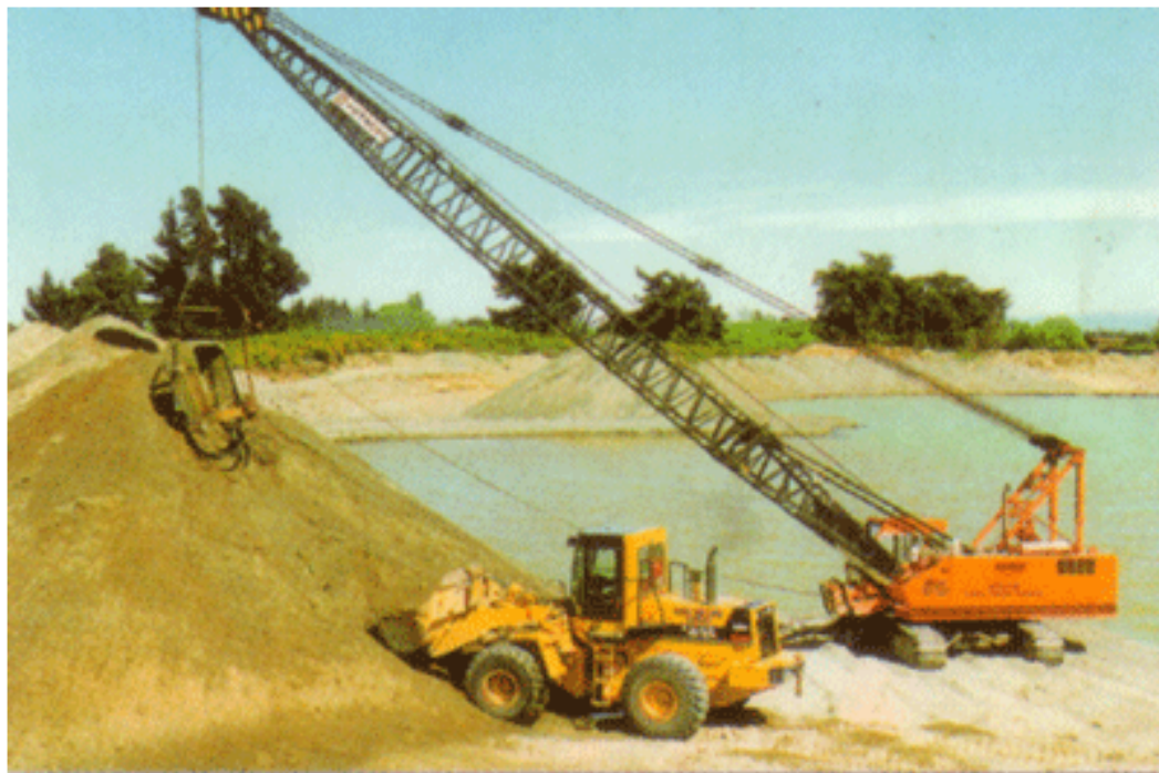
Figura 4.6 - Fotografia ilustrativa do processo de dragagem de areia com "Drag Line" 4
