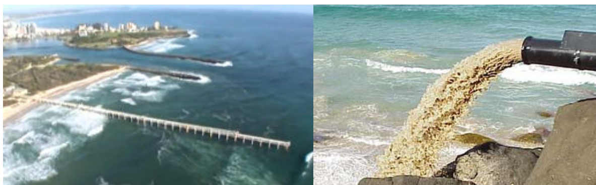
Figura 4.4 - Visão Geral da Estrutura fixa para o sistema de bombas de sucção (esquerda) e linha de recalque e do ponto de descarga na erosão máxima (direita) 3
