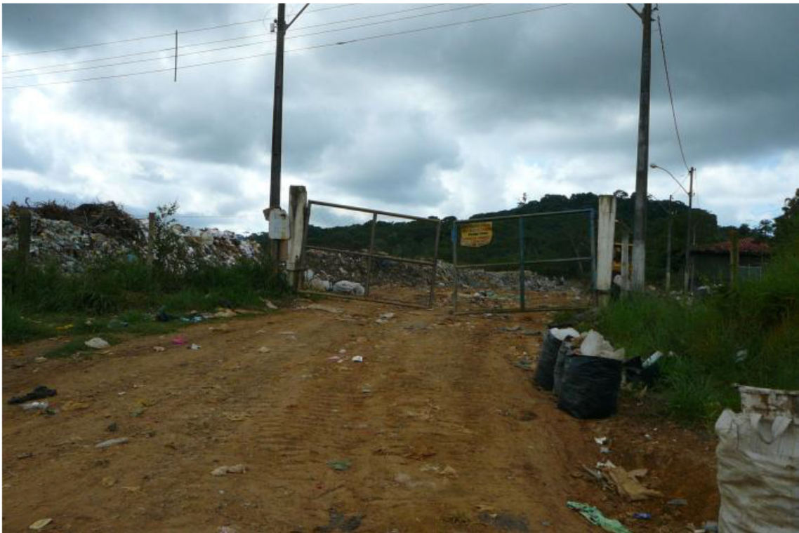
Foto 2.2 - Entrada do Lixão em Itariri (HYDROS ORIENTA, 2012)
