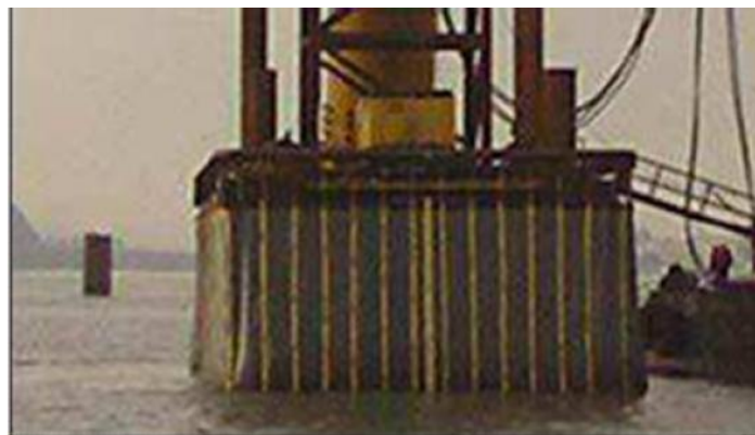
FIGURA PD1b (1): Cortina de Bolhas Confinadas (Reyff, 2004)
