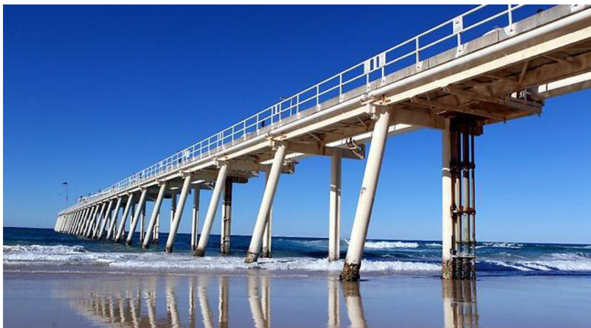
Figura 3.2 - Estrutura fixa para o sistema de bombas de sucção e linha de recalque
