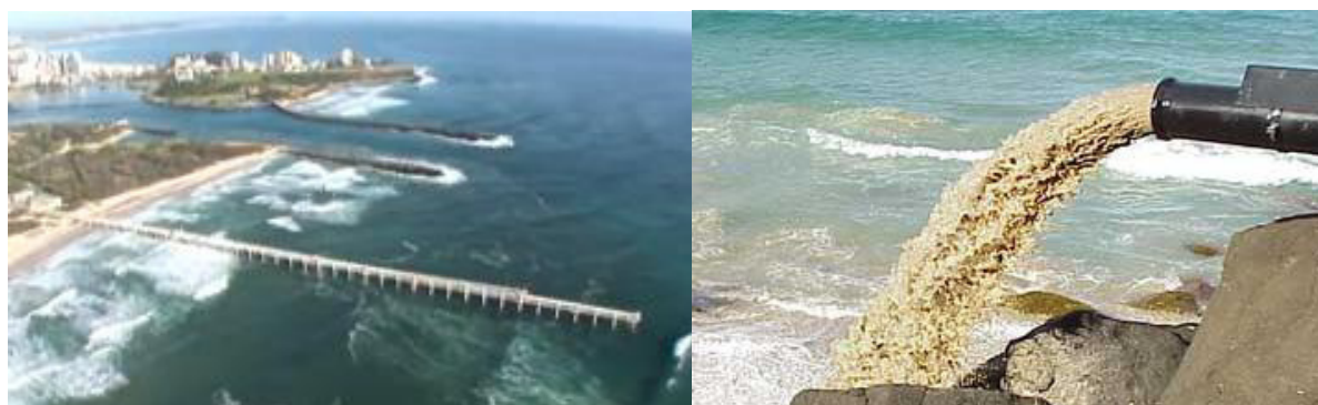
Figura 3.4 - Visão Geral da Estrutura fixa para o sistema de bombas de sucção e linha de recalque e do ponto de descarga na erosão máxima
