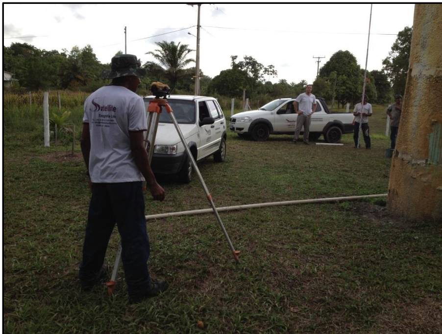
Figura 5: Procedimento de coleta das coordenadas altimétricas.
