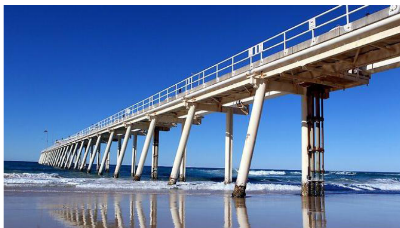
Figura 9-1 Ilustração do sistema de transpasse de sedimento (Tweed River, Australia)
