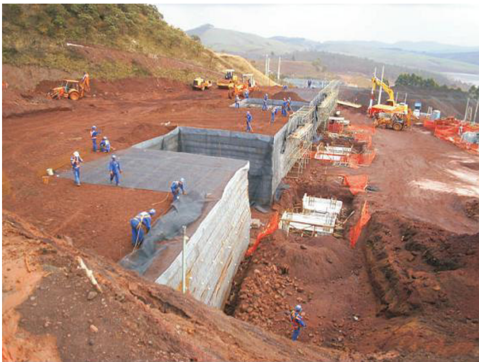
Figura 7.2 - Solo reforçado com geogrelha.
