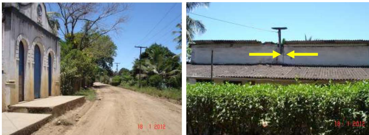
Figura 6.8: Edificações Existentes ao Longo da BA-648 no Trecho de São João de Aritaguá: Igreja de Nossa Senhora de Lourdes, datada de 1904 (à esquerda) e Evidência de Residência Comprometida Estruturalmente – Fissura Aparente Indicada pelas Setas em Amarelo (à direita).
