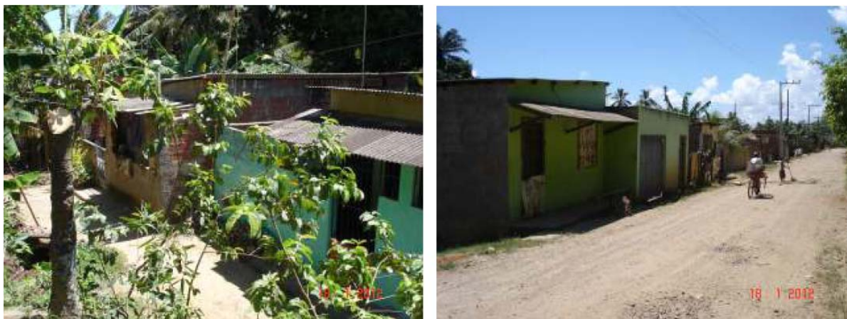
Figura 6.5: Edificações Existentes ao Longo da Estrada Centenária no Trecho do Distrito de Aritaguá.
