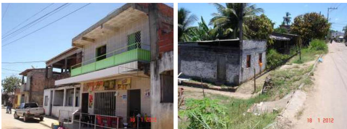
Figura 6.9: Edificações Existentes ao Longo da BA-648 no Trecho de Iguape.
