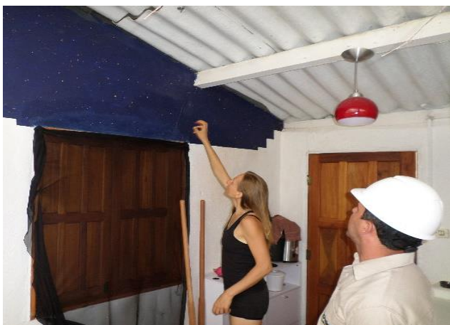
Figura 2 - Vistoria em imóvel rural. Região da Carobeira, Ilhéus, 19/02/14.
