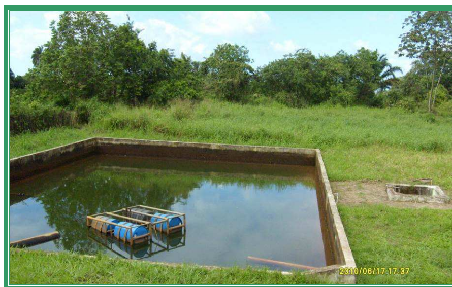
Foto 10 – Vista do reservatório de reaproveitamento
