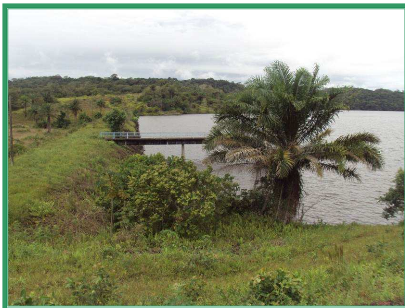
Foto 1 – Vista geral da Barragem do Iguape
