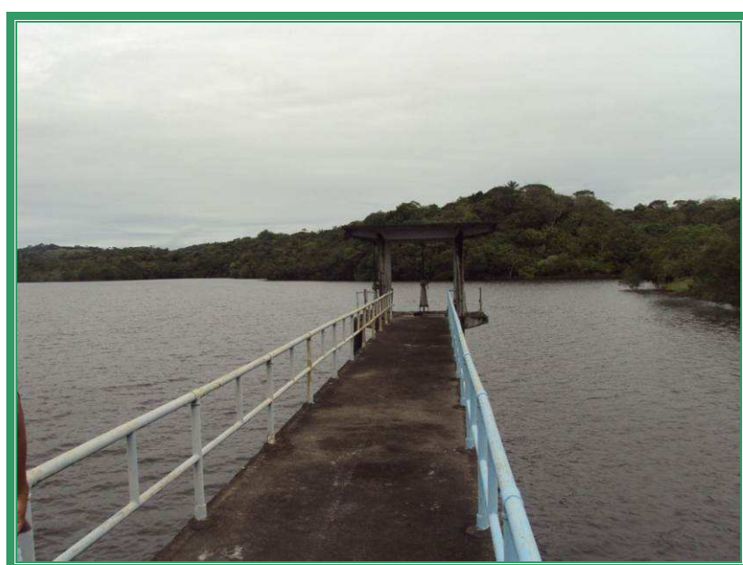
Foto 2 – Vista frontal da estrutura da tomada d'água
