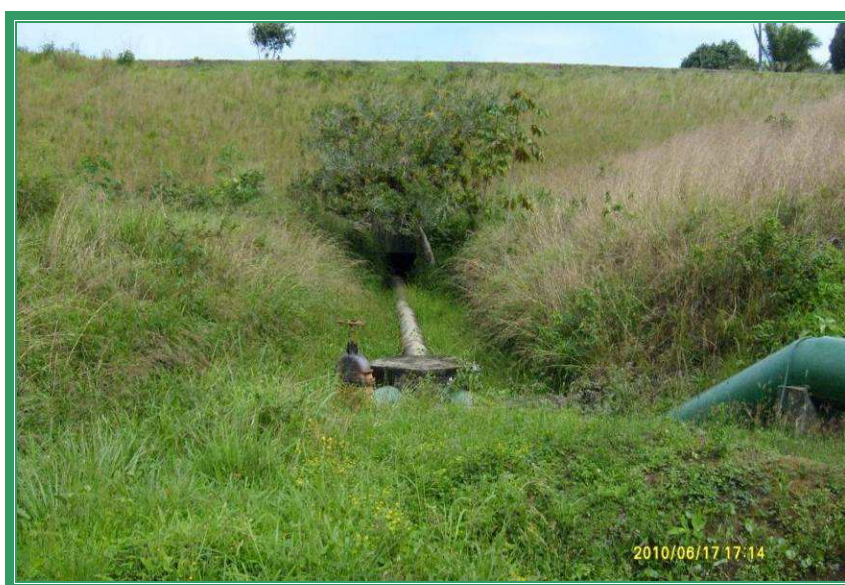
Foto 3 – Vista frontal da galeria e tubulação da tomada d'água
