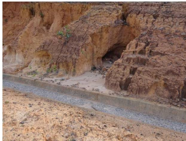
**Figura 4.14-** Erosão em talude de corte protegido por canaleta de drenagem
