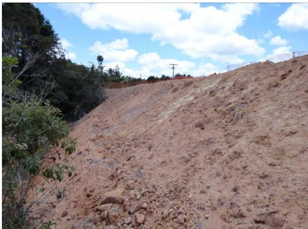
**Figura 4.13-** Talude de aterro com material desagregado desprotegido, suscetível a erosão
