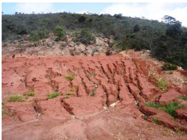
Figura 4.11- Cicatrizes de erosão em um talude de corte de estrada
