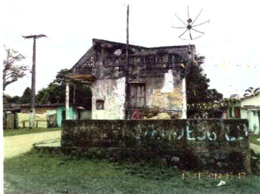
Fig. 09 – Vista da fachada lateral
