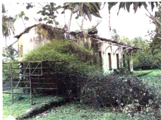
Fig.3- Vista Gera do prédio.
