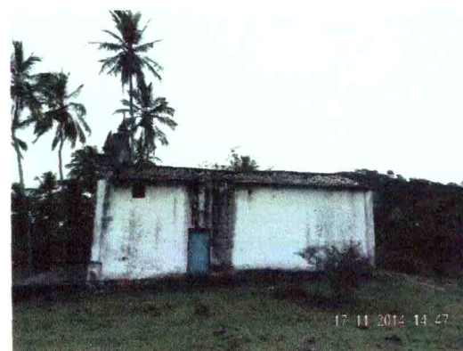
Fig.8 - Vista da fachada lateral.
