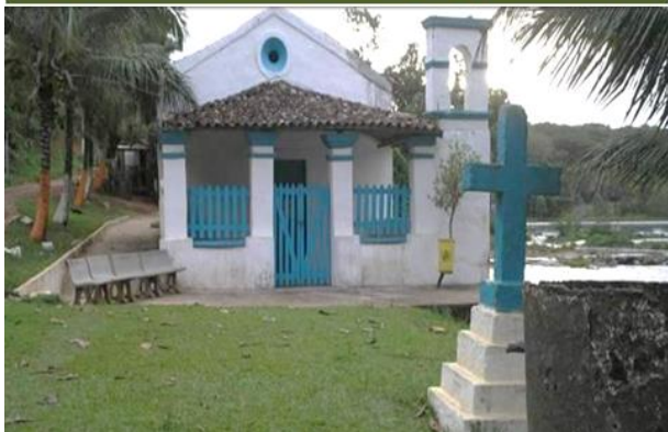
CAPELA DO ENGENHO DE SANT'ANA (Edificação)
