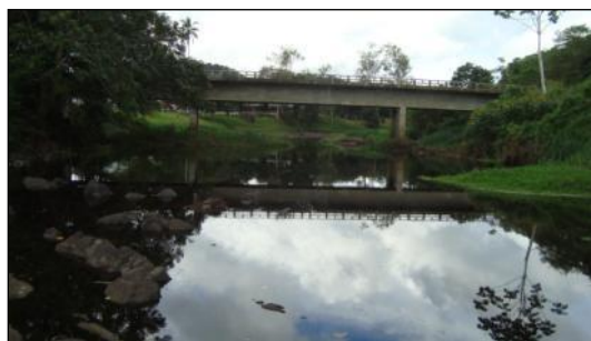
Figura 8.1.1.4.4 - Vista da Ponte sobre o Rio Almada na Rodovia BA 262 Ilhéus-Uruçuca Situada a Jusante da Estação AL1
