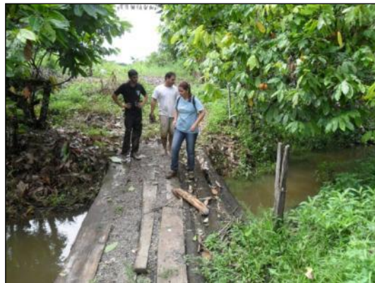
Figura 8.1.1.4.59 - Ponte de Madeira sobre Valeta
