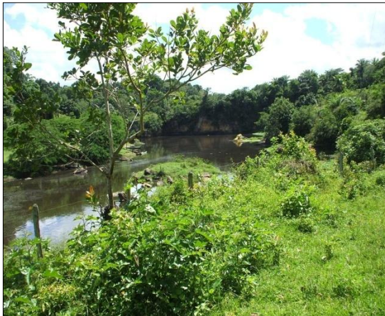
Figura 8.1.5.1.14 - Ao fundo Captação Flutuante do SAA de Itabuna
