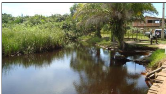
Figura 8.1.1.4.32 - Visão Geral da Estação P1, Área Diretamente Afetada, a Montante de Ponte Sobre o Rio Sonrisal
