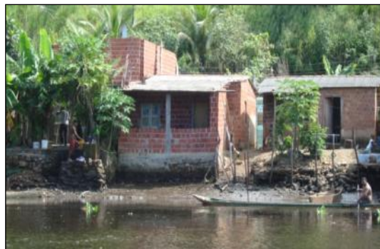
Figura 8.1.1.4.18 - Construções Consolidadas da Vila de Aritaguá, na Margem Direita do rio Almada
