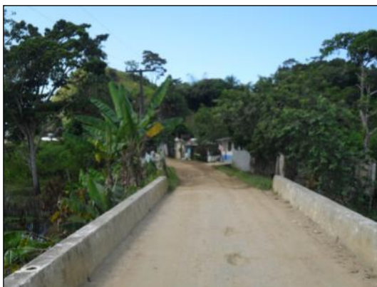
Figura 8.1.1.4.52 - Ponte Sobre Rio Tiriri Situada a Jusante da Estação C03. Próximo à Vila de Urucutuca
