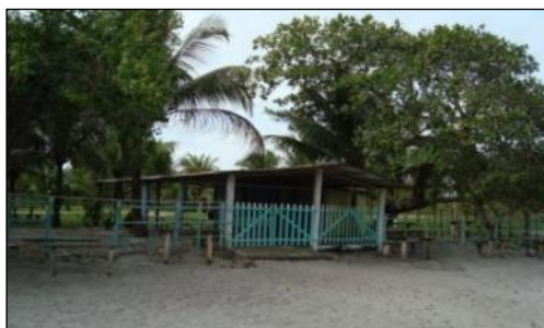
Figura 8.1.1.4.13 - Detalhe de Construção Consolidada Pertencente a Balneário (Coordenadas 490.766 e 8.380.431) Situado na Margem Esquerda do Rio
