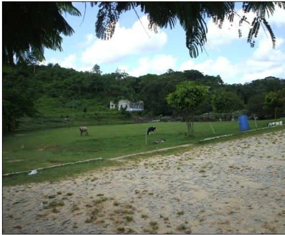
Figura 8.1.5.1.12 - Vista geral da PCH Desativada a partir da Margem Esquerda
