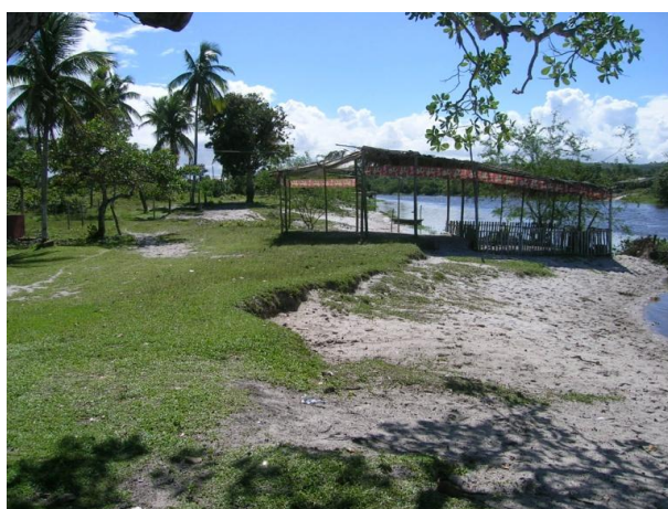
Figura 8.1.3.1. - Depósitos Arenosos dos Terraços Marinheiros Holocênicos, nas Margens do Rio Almada na Localidade de Sambaituba. Em Ambos os Lados do Rio Ocorrem Depósitos Fluviais
