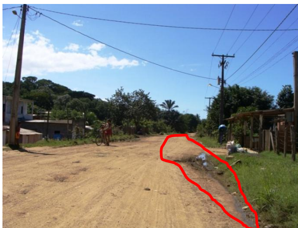
Figura 8.3.4.6.38 - Lançamento de Efluentes Domésticos a Céu Aberto - Comunidade de São João
