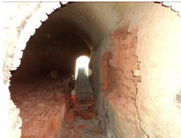
Figura 8.3.5.3.22 - Olaria na Vila São José: Forno de Queima dos Blocos
