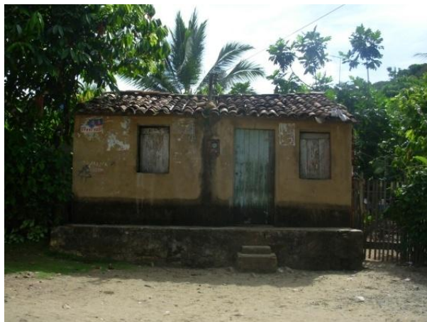
Figura 8.3.3.2.27 - Casa com Base Alta para Evitar Alagamento pelo Aumento do Volume do Lençol Freático na Comunidade de São João
