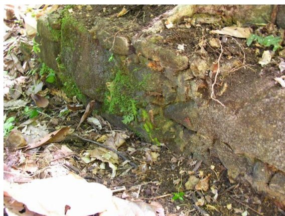
Figura 8.3.5.2.84 - Ruínas do Engenho de Cana de Açúcar, em Alvenaria de Pedra e Cal
