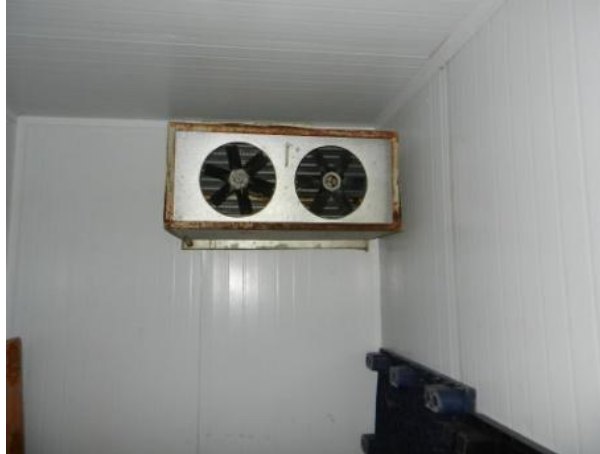
Equipamento de frio subutilizado devido a erro na avaliação da produção para o local
