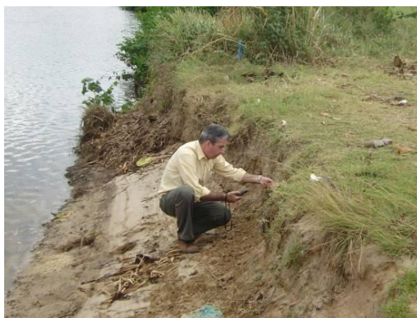
Figura 8.3.5.2.30 - Vistoria da Margem Esquerda do Rio Almada, Próximo a Iguape. Coordenadas UTM 24 L 492941 8371342
