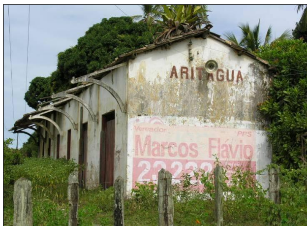
Figura 8.3.5.2.50 - Estação Ferroviária de Aritaguá, Construída em 1910. Atualmente Abandonada. Apesar de ser um Bem Histórico do Município, o Prédio foi Utilizado por Candidato a Vereador para Propaganda Política, Pintando-se seu Nome e Número na Fachada da Estação
