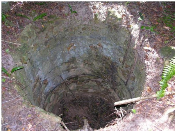
Figura 8.3.5.2.44 - Poço em Alvenaria de Pedra e Cal e Tijolo. Coordenadas UTM 24 L 492233 8376560
