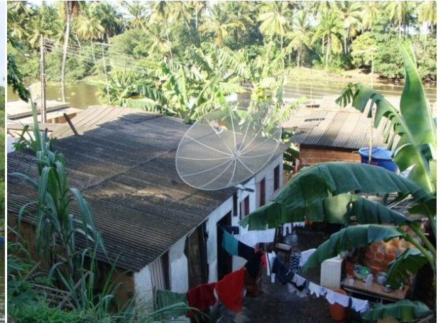
Figura 8.3.4.6.40 - Ocupação às Margens do Rio Almada
