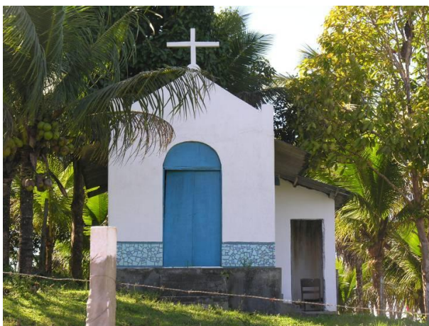
Figura 8.3.5.2.59 - Capela Nossa Senhora da Conceição. Coordenadas UTM 24L 480395 8378347
