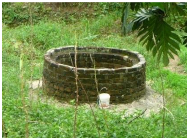
Figura 8.3.2.8.7 - Poço de Abastecimento de Água - Vila Olímpio
