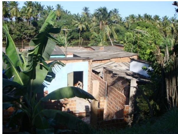
Figura 8.3.4.6.41 - Ocupação às Margens do Rio Almada
