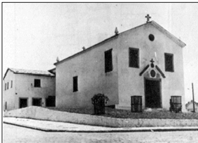
Fonte: IPAC, Secr. Cultural - Bahia Figura 8.3.5.1.5 - Igreja de Nossa Senhora de Escada
