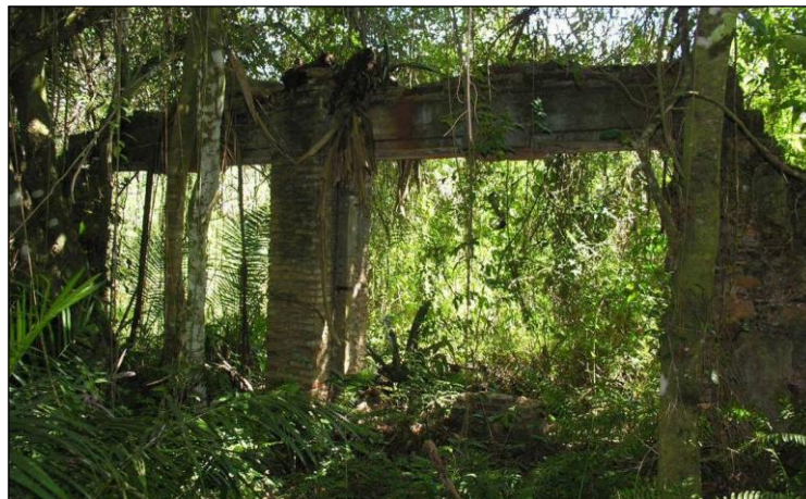
Figura 8.3.5.2.41 - Ruínas em Alvenaria de Pedra e Cal e Tijolo. Coordenadas UTM24 L 492215 8376581
