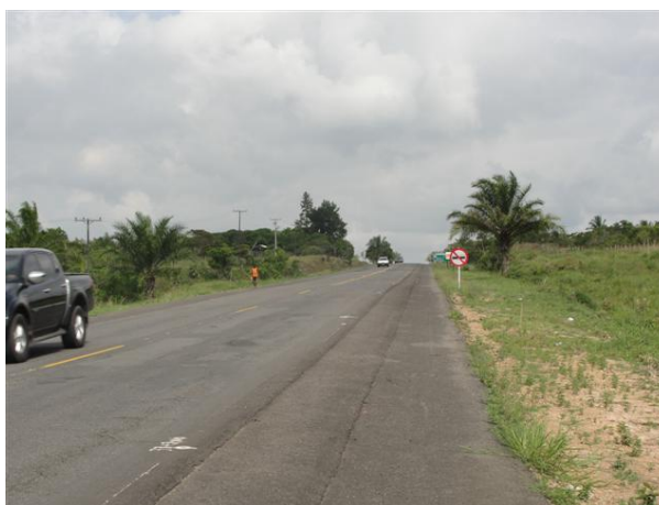
Figura 8.3.4.5.1 - Vista da Rodovia BA-001
