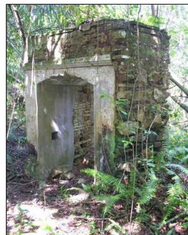
Figura 8.3.5.2.43 - Ruínas em Alvenaria de Pedra e Cal e Tijolo
