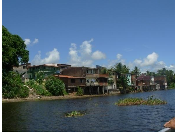
Figura 8.3.3.2.26 - Assentamento de Pescadores em Área de Risco por Estar Inserida na Planície de Inundação do Rio na Sede Municipal, Rua Ouvídio Leal
