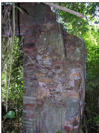
Figura 8.3.5.2.42 - Coluna em Alvenaria de Pedra e Cal e Tijolo
