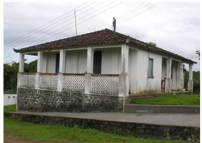
Figura 8.3.5.2.26 - Antiga Casa Sede da Fazenda. Coordenadas UTM 24 L 495271 8365690
