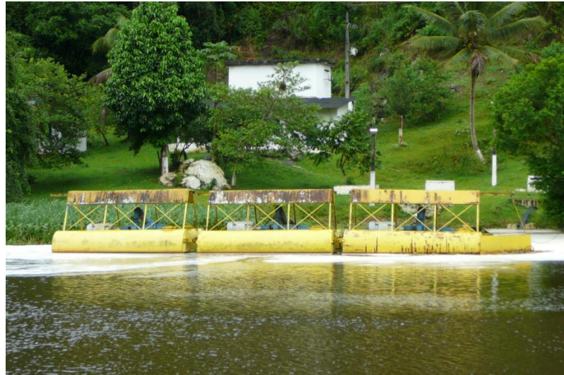
Figura 8.3.2.8.6 - Ponto de Captação para Abastecimento de Água de Itabuna - Castelo Novo, 2010
