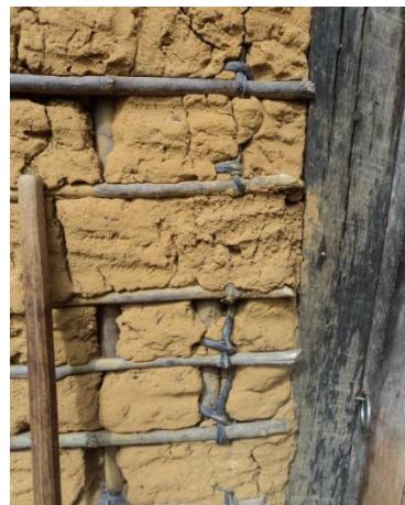
Figura 8.3.5.3.9 - Detalhe da Casa: amarração da Estrutura com Cipó Imbé. Pau-a-pique
