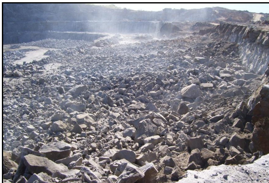
Figura 5.48 - Exemplo de Detonação, com Fragmentação de Rocha Adequada para Enrocamento
