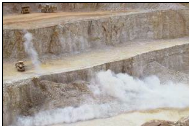
Desmonte por Explosivos
