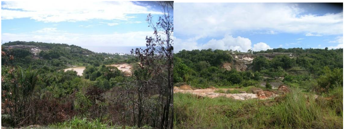
Figuras 5 e 6 - Coord. UTM: 24L; 495740 / 8350201. Litoral Sul de Ilhéus: Passivo de Antiga Extração de Material de Empréstimo (Areia e Arenoso)
