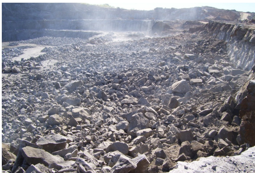
Figura 5.10: Exemplo de detonação, com fragmentação de rocha adequada para enrocamento
