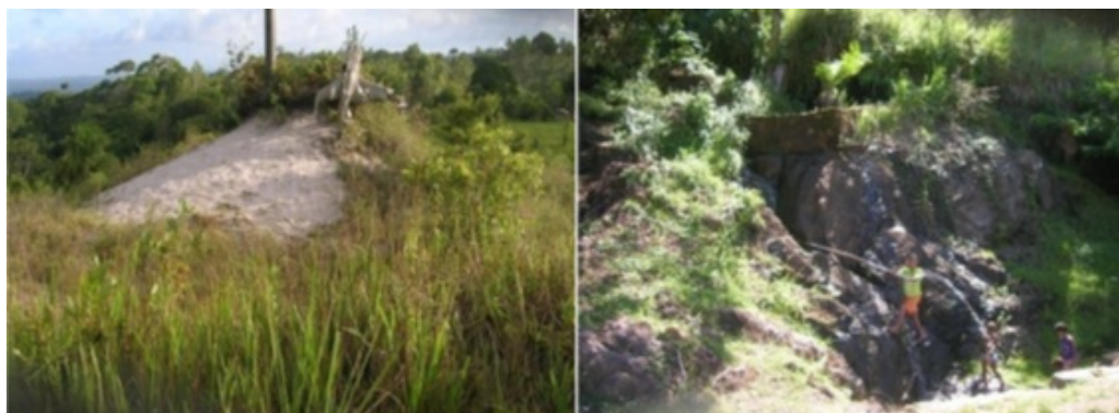
Figura 6.30: Parte superior do Sistema B desenvolvido sobre os Sedimentos Barreiras / Figura 6.31: Minação em fraturas das Rochas Cristalinas na parte inferior da Falésia – Estrada Ilhéus – Sambaituba. Fonte usada pela população de Aritaguá e usuários da estrada
