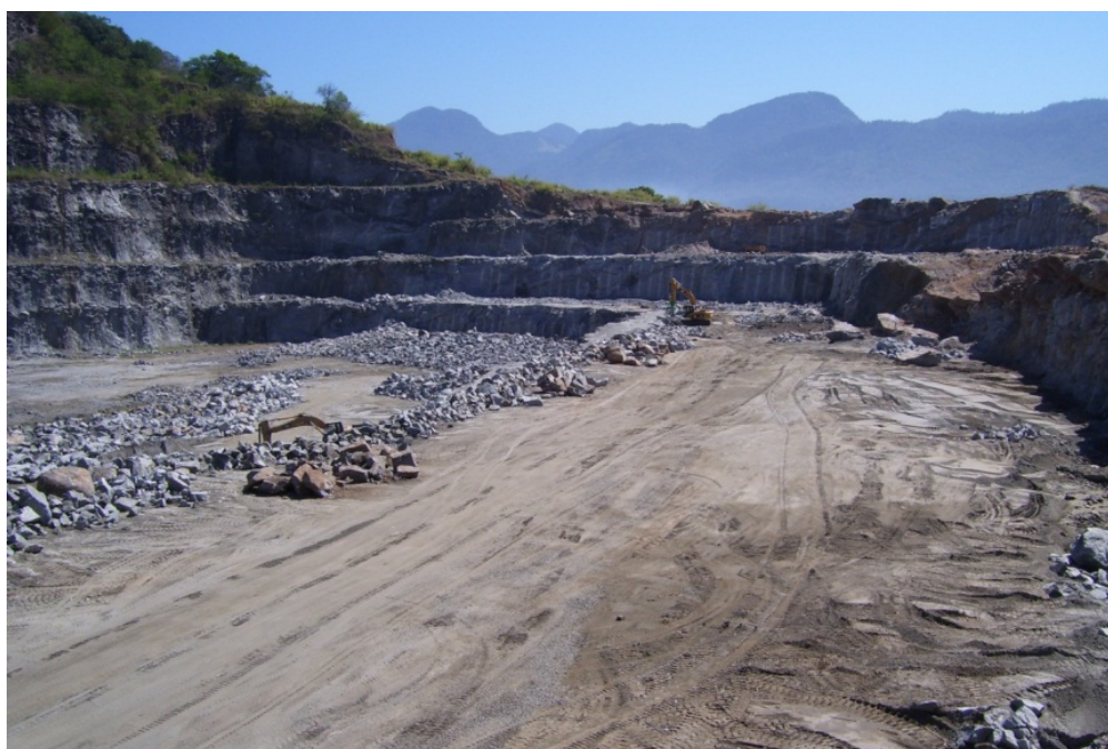
Figura 5.9: Exemplo de Praça de Trabalho de pedreira
