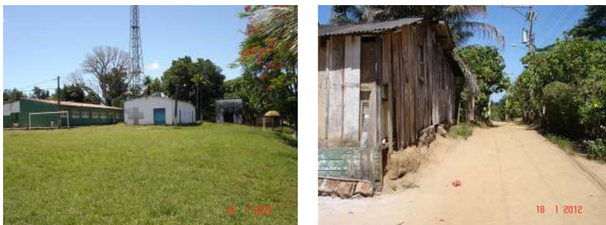
Figura 6.52: Edificações das vilas Carobeira de Baixo (esquerda) e Carobeira de Cima (direita).
