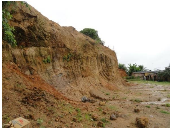
Foto 7 - Coordenadas: 489029 / 8379517 Área Urbana de Sambaituba
