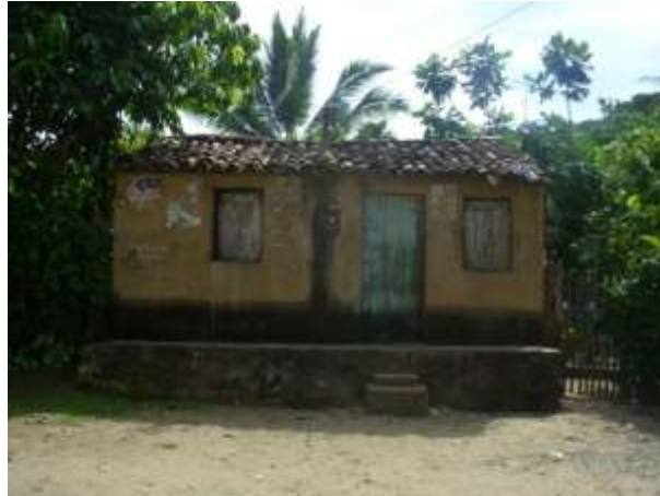
Figura 2.11 - Casa com Base Alta para Evitar Alagamento pelo Aumento do Volume do Lençol Freático na Comunidade de São João
