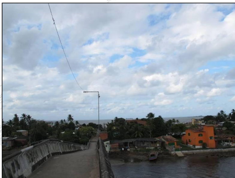
Figura 03 – Local mais elevado da ponte no bairro de São Miguel utilizado com ponto para aplicação do método “intersecção avante”.
