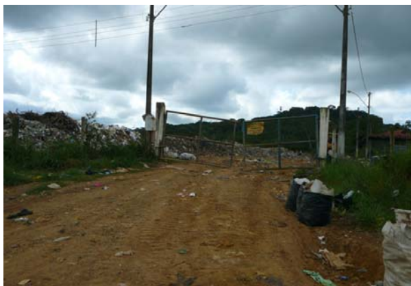
Figura 1.37 - Entrada do Lixão em Itariri
