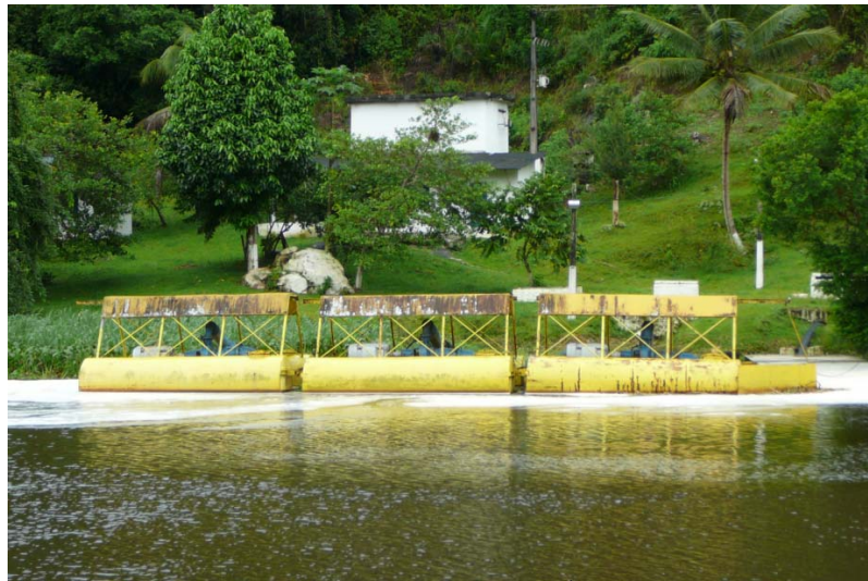
Figura 1.31 - Ponto de Captação para Abastecimento de Água de Itabuna - Castelo Novo, 2010
