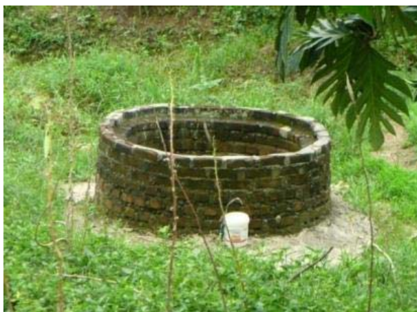
Figura 1.32 - Poço de Abastecimento de Água - Vila Olímpio
