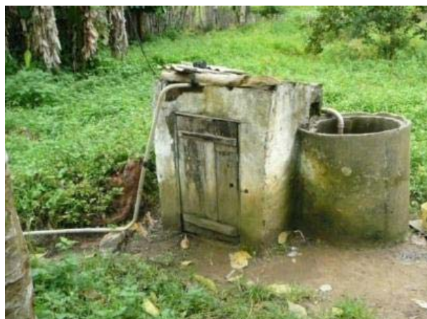
Figura 1.33 - Sistema de Abastecimento de Água
