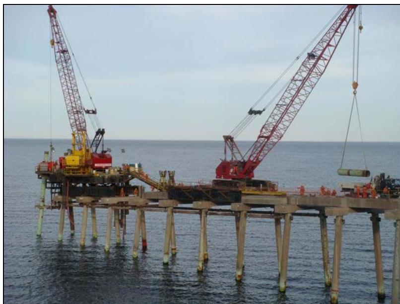
Figura 6.2 - Construção Cantitravel Típica.
