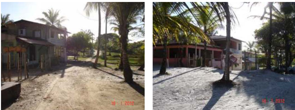
Figura 6.10: Edificaes do Condomnio Japar, na Proximidade da Ponte Onshore-Offshore .
