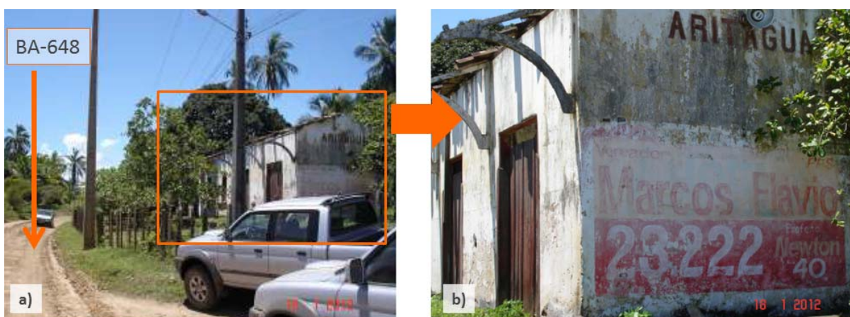
Figura 8.3: Obra de Arte Associada ao Patrimônio Histórico da Região na Rodovia BA-648: a) Localização da Antiga Estação Ferroviária de Aritaguá à Margem da Rodovia, e b) Zoom sobre a Edificação.
