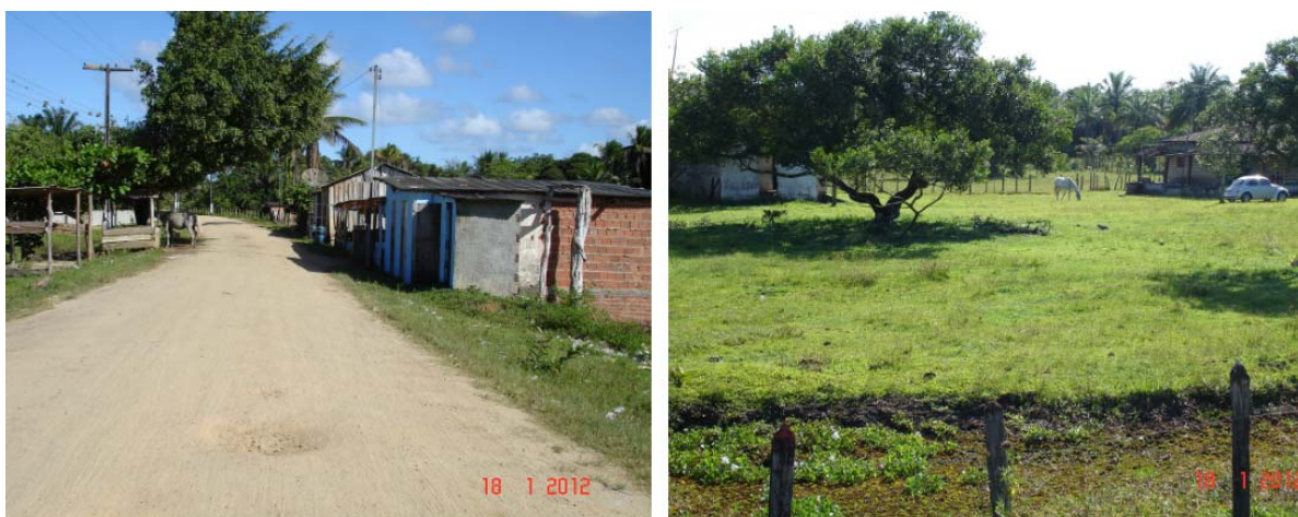
Figura 6.14: Edificações da Vila de Campinhos (esquerda) e da Vila Olimpo (direita).
