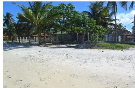
Figura 2.41 - Visão Geral de Construções Consolidadas - 13/03/2012
