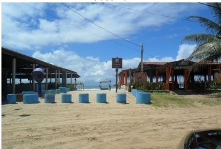
Figura 2.23 - Visão Geral de Estrutura Existente na Praia da Jóia - 21/03/2012
