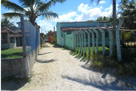
Figura 2.42 - Acesso para a Estação 5
