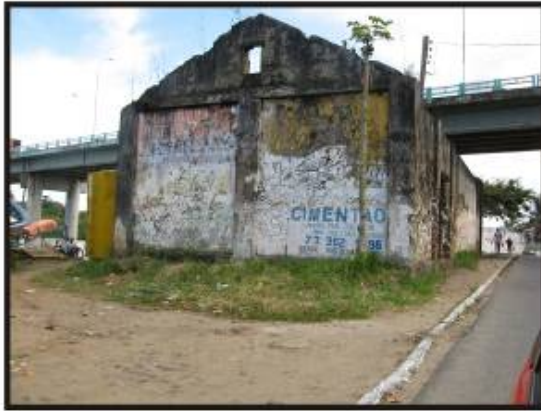
Antiga Tercena ou Armazém Construído em Pedra às Margens da Baía
