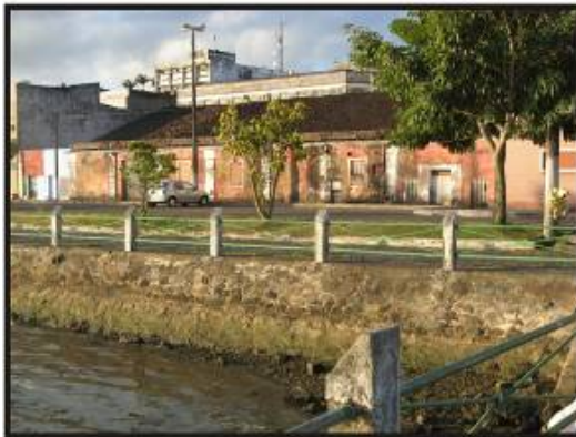
Antigo armazém localizado no trecho de expansão construído em meados do século XX
