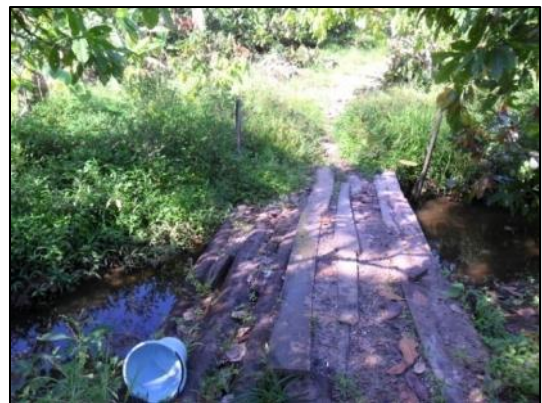
Figura 2.72 - Ponte de Madeira sobre Valeta (Período Seco)
