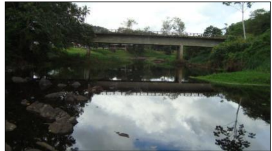
Figura 2.4 - Vista da Ponte sobre o Rio Almada na Rodovia BA 262 Ilhéus-Uruçuca Situada a Jusante da Estação AL1
