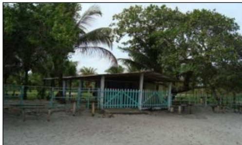
Figura 2.13 - Detalhe de Construção Consolidada Pertencente a Balneário (Coordenadas 490.766 e 8.380.431) Situado na Margem Esquerda do Rio Sentido Jusante
