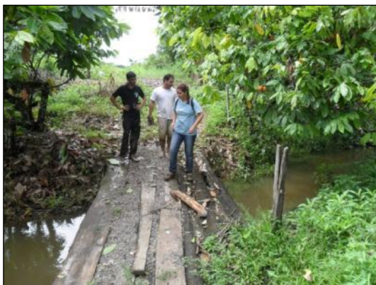
Figura 2.71 - Ponte de Madeira sobre Valeta (Período Chuvoso)
