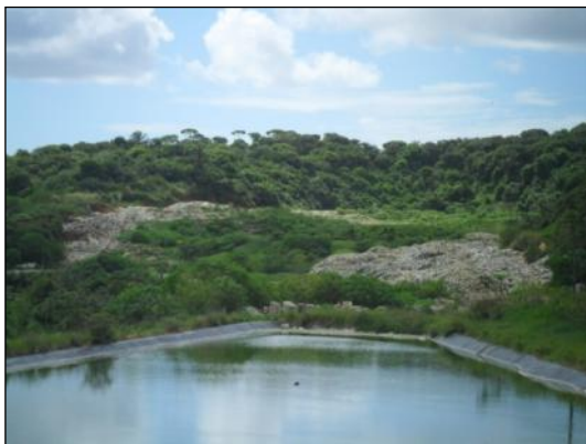
Figura 2.37 - Visão Geral de Lagoa de Chorume e Local Onde é Depositado o Lixo
