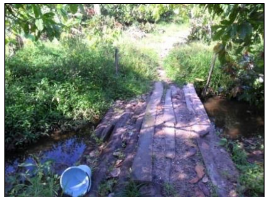
Figura 2.72 - Ponte de Madeira sobre Valeta (Período Seco)
