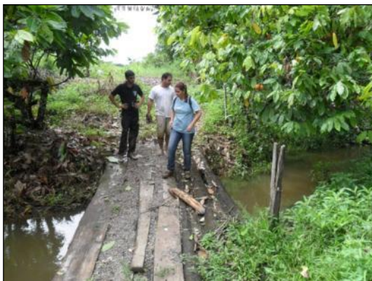
Figura 3.70 - Ponte de Madeira sobre Valeta (Período Chuvoso)
