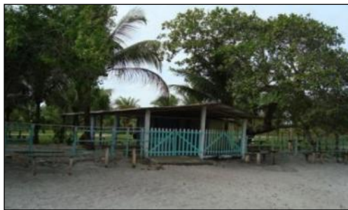
Figura 3.12 - Detalhe de Construção Consolidada Pertencente a Balneário (Coordenadas 490.766 e 8.380.431) Situado na Margem Esquerda do Rio Sentido Jusante
