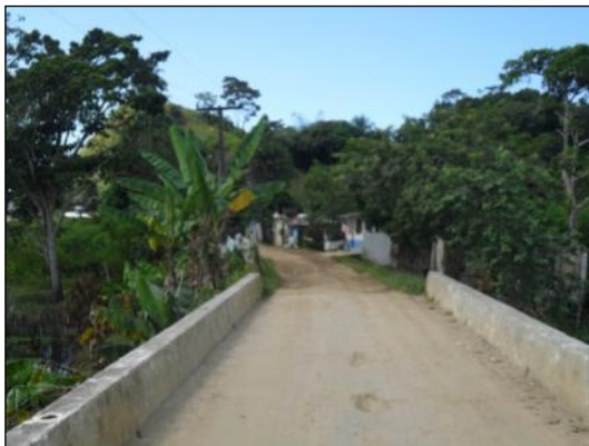
Figura 3.59 - Ponte Sobre Rio Tiriri Situada a Jusante da Estação C03. Próximo à Vila de Urucutuca (Período Chuvoso)
