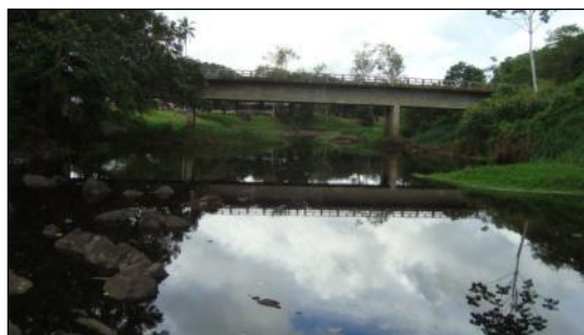
Figura 3.3 - Vista da Ponte sobre o Rio Almada na Rodovia BA 262 Ilhéus-Uruçuca Situada a Jusante da Estação AL1
