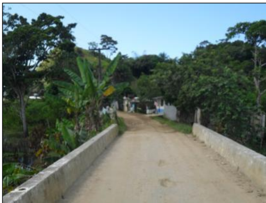
Figura 3.18 - Ponte Sobre Rio Tiriri Situada a Jusante da Estação C03. Próximo à Vila de Urucutuca
