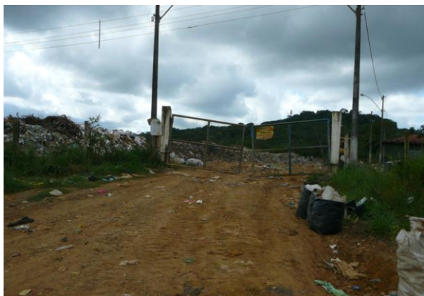
Figura 2.1 - Entrada do Lixão em Itariri
