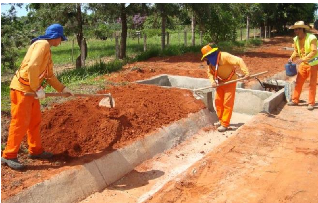
Foto 5.2-Limpeza manual de dispositivo de drenagem
