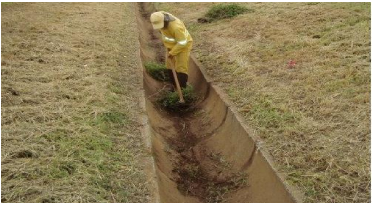
Foto 5.1- Limpeza manual de dispositivo de drenagem
