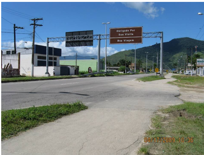
Figura 5.3.3.4.2- 2: Eixo Viário Principal de São Sebastião - extremo norte junto à divisa São Sebastião / Caraguatatuba (vista para sul)
