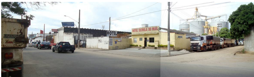
Figura 5.3.4.3.2-3: Esquina da Rua Piauí com a Rua Leme. (Fonte vistoria SAU)
