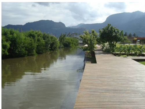
Figura 5.3.4.2.1-18: Passadiço da orla do córrego do Outeiro. (Fonte: vistoria SAU)
