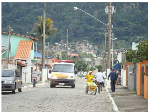
Figura 5.3.4.2.1-6: Rua Santiago, na planície do bairro Topolândia. (Fonte: vistoria SAU)
