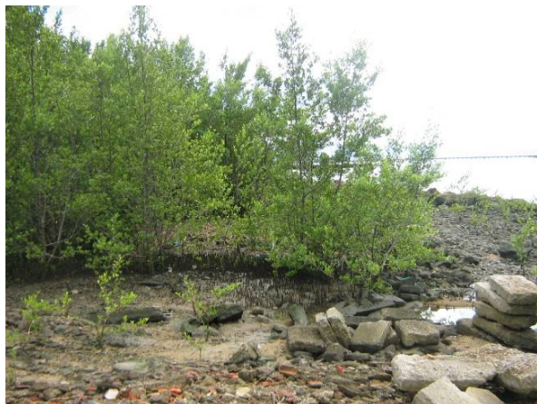
Figura 5.2.1.1.4-10: Enrocamento que circunda o fragmento mg4, criando um ambiente deposicional propício ao estabelecimento do manguezal. Detalhe do canal por onde penetra água do mar.
