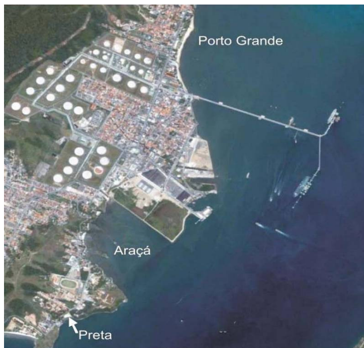
Figura 5.2.2.1 - 27: Vista aérea da região em destaque na Figura 5.2.2.1 - 26, ilustrando os três ambientes de estudo (Praia Preta, Região do Araçá e Porto Grande).
