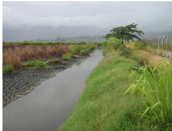
Figura 5.2.1.1.4-7: Canal de drenagem em área secundária da CDSS. À esquerda, substrato exposto. À direita, vegetação ruderal, com presença de árvores isoladas como chapéu-de-sol ( Terminalia catappa ).
