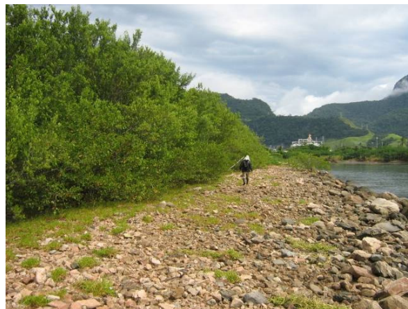
Figura 5.2.1.1.4-11: Enrocamento que circunda o manguezal mg4, que propiciou a deposição de sedimentos finos e a colonização por espécies de mangue.
