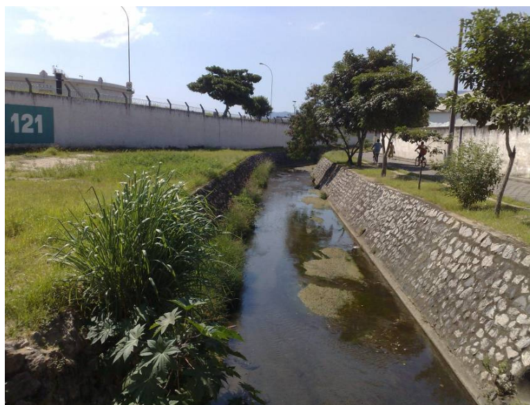
Figura 5.1.7.1.1 - 6: Vista do canal com talude de pedra de mão e fundo de concreto do córrego Mãe Izabel no trecho final, junto à área da Petrobras (à esquerda)
