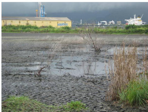
Figura 5.1.3.4.2 - 1: Parte do Pátio 4, parcialmente inundado por águas pluviais.
