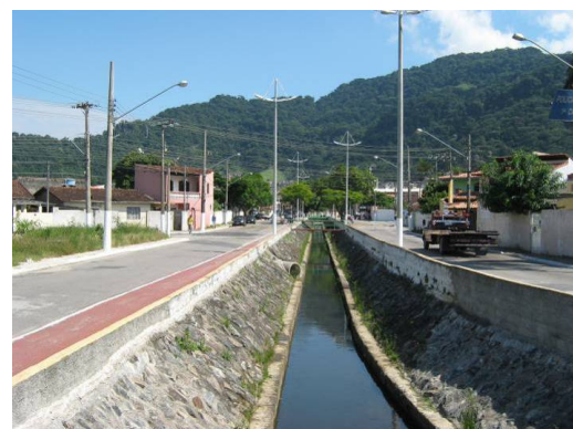
Figura 5.1.3.4.1 - 2: Córrego Mãe Izabel canalizado, em meio a área urbana
