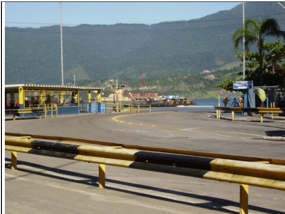
Figura 2.4.2.1 - 4: Acesso à balsa
