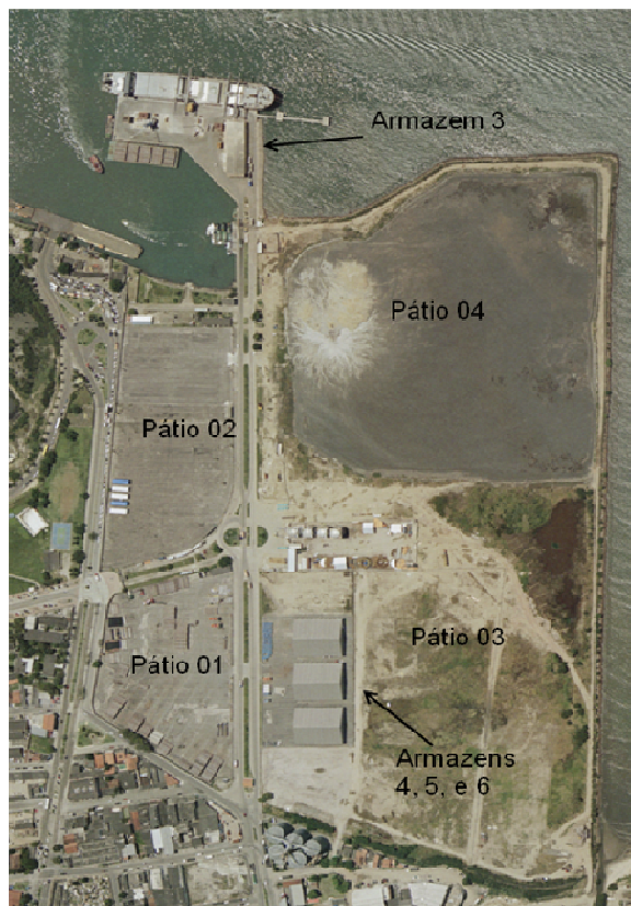
Figura 2.4.3.4 - 1: Instalação de armazenagem
