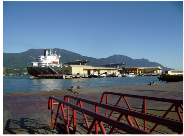
Figura 2.4.2.1 - 5: Acesso à balsa com vista para o Porto
